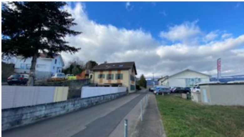
Vue sur l'immeuble depuis l'entrée du chemin
